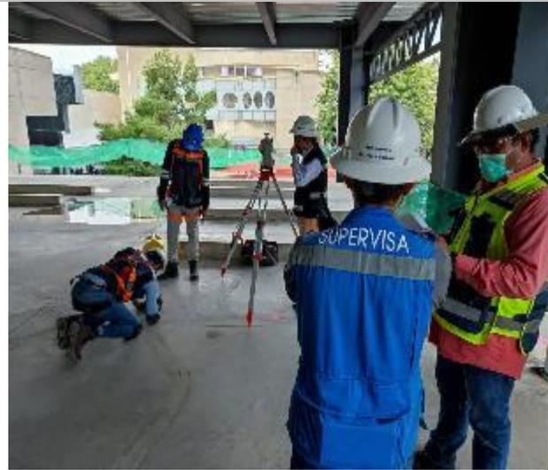
Trazo Topográfico en muros de albañilería, Planta Baja y Primer Nivel
