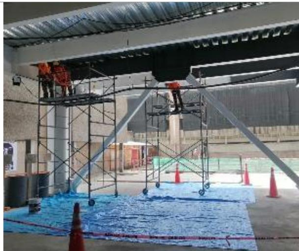
Aplicación de pintura intumescente en las columnas en Planta Baja.
