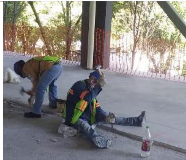
Perfilado de pisos derivado del trazo topográfico, Planta Baja y 1er.Nivel.
