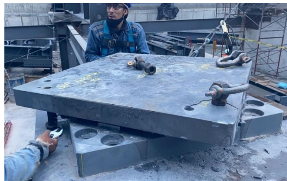
Colocación de Aislador sísmico
