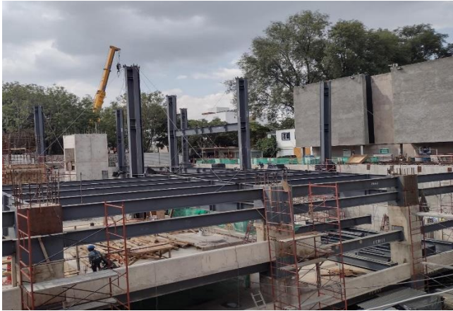
Colocación de traves secundarias en planta baja
