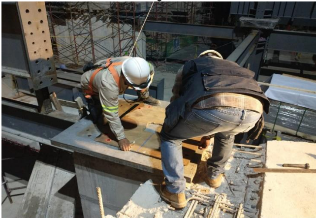
Preparación Placa Base para recibir Aislador Sísmico
