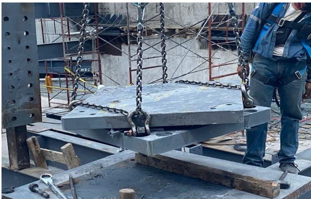
Colocación de Aislador sísmico
