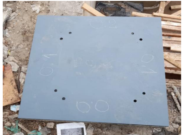
Preparación Placa Base para recibir Aislador Sísmico
