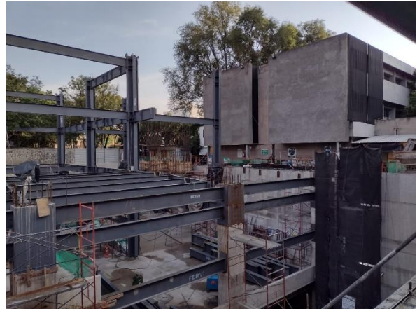
Colocación en traves 1er nivel
