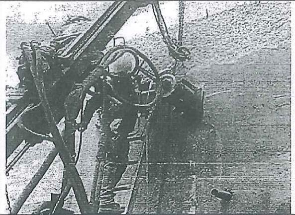
Tensado de anclas en muros eje 5, patio ingles.
